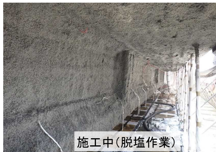
飛来塩分による劣化
